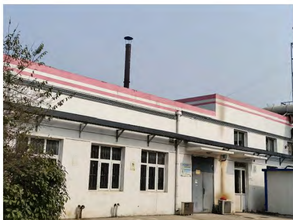
天然气锅炉排放口[DA008]
