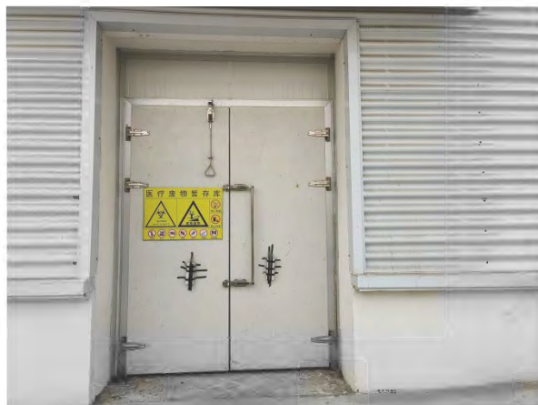
新建医疗废物暂存库
