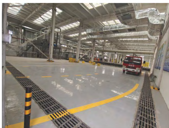
新建高温蒸煮车间（导流槽）
